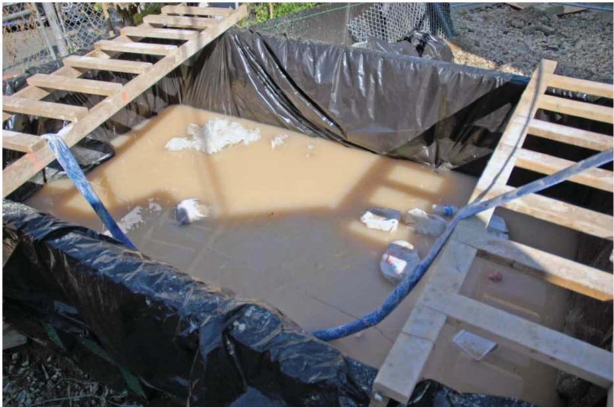
Figura No. 122 – Ejemplo de Tina de Lavado de Concreto
